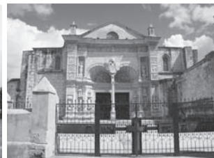
コロンブス広場(北面)から見た大聖堂である。広場はいつも人が一杯でこうした光景は極めて珍しい。幸運だった。
