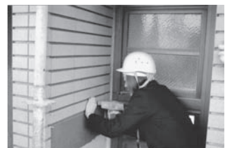
NPOファサード再生プロジェクト(タイル貼りの様子)
