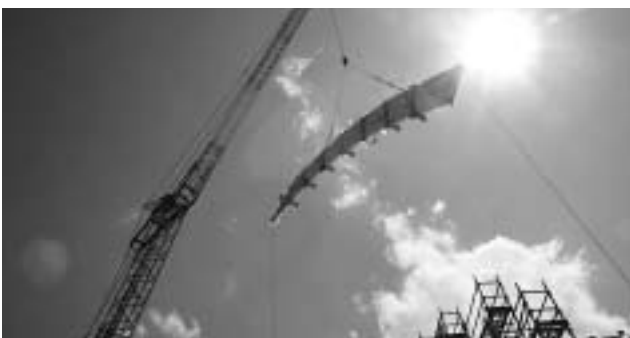
最後のアーチ梁が揚げられました
