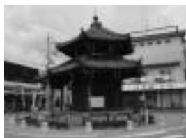
六角堂周辺はポケットパークとして整備されている
