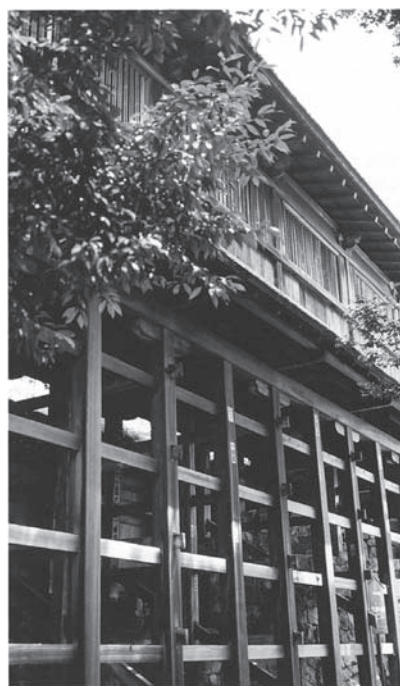
参道途中の渡り廊下(重文)
