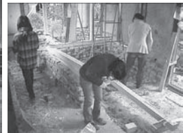
改修作業の様子
