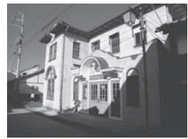
②旧八幡郵便局舎 改修後
