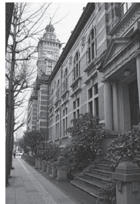
開港 50 周年を記念して建てられた横浜市開港記念会館。
