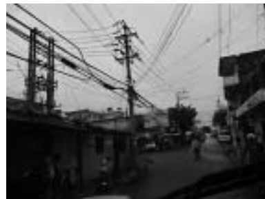
電柱と入り乱れた電線が物語る。きちんと管理できていないので盗電も日常茶飯事のようなのだ。
