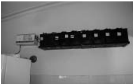
家庭内の蓄電池である。通電中に蓄電して停電に備える。
