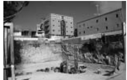
土工事であるが、土止がないのでびっくりした。雨が降っても崩れることはないようである。
