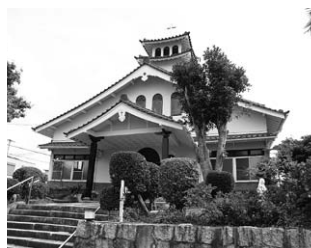
カトリック大津教会外観
