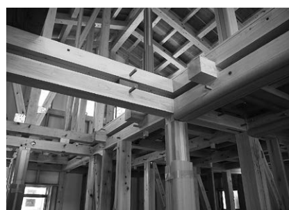
二重梁井桁工法の軸組み
