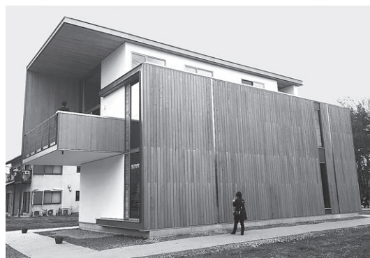
参考写真：CLTつくば実験棟
