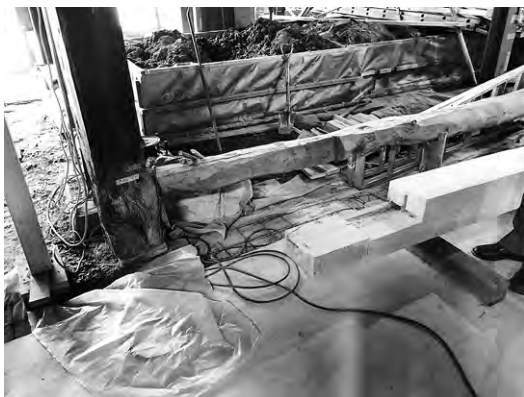
根継ぎする柱・再利用する土
