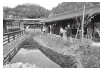
高森復興公営住宅
