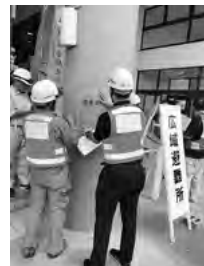
応急危険度判定ステッカーの貼りつけ
