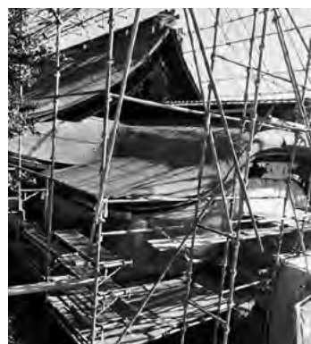
唐門保存修復工事
