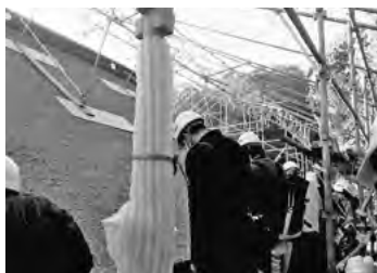
足場にて保存修復工事見学
